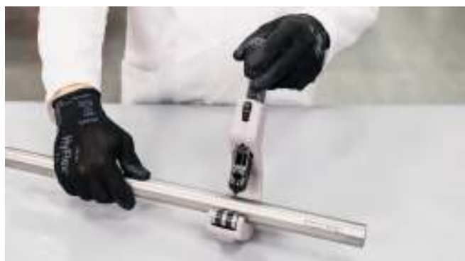
Рис. 25. Резка трубы.
